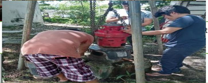
Reparación del motor de 7.5 hp del subsistema de agua potable de la comisaría de Ucí.
